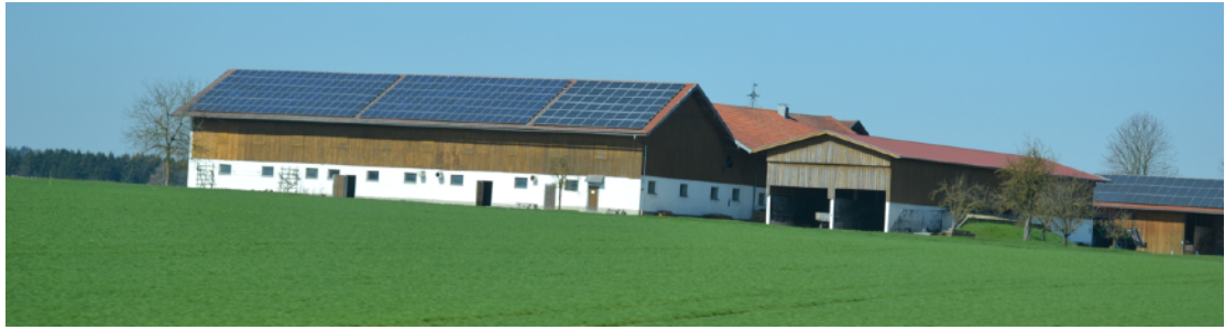
Figura 3: Painéis fotovoltaicos em propriedade rural (Baviera, Alemanha – 2017)
